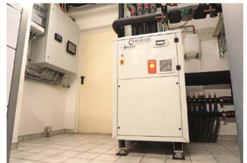
Die zweistufige Wärmepumpe von Rhoss ist der Kern der Heiz- und Kühlanlage.
