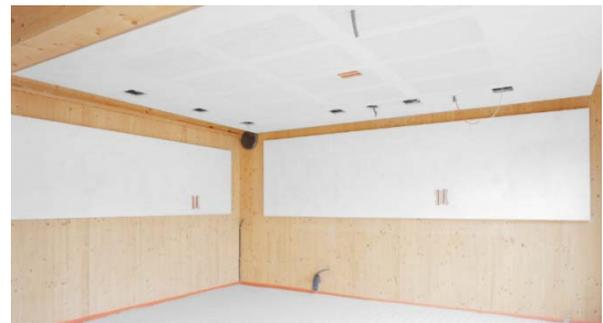
Die Heizung und Kühlung im Trockenbau wurde an einer Metallunterkonstruktion installiert.
